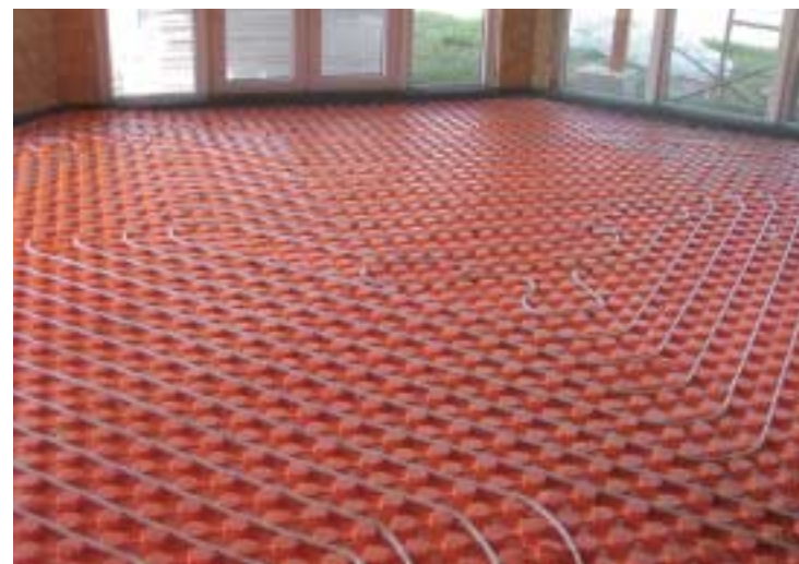
Typické řešení pro podlahové topení v rodinném domě - sys. deska TH 30P s potrubím Alpex
