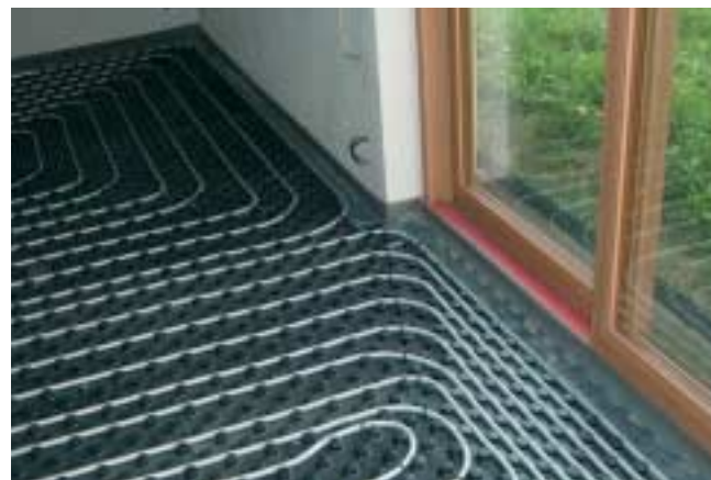
Detail využití možnosti systémové desky k aplikaci zhuštěné okrajové zóny s větším topným výkonem před francouzským oknem
