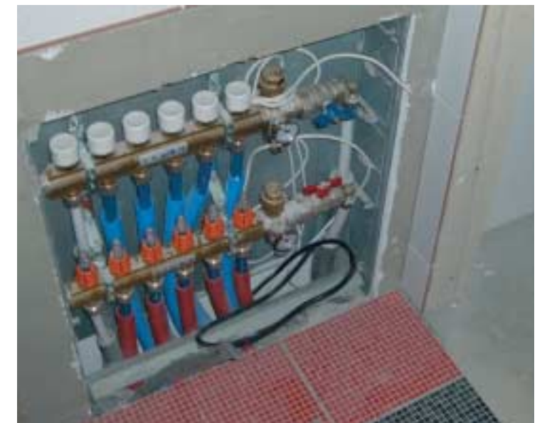
Nesměšovaná rozdělovací sestava CS 553 VP v podomítkové skřínce
