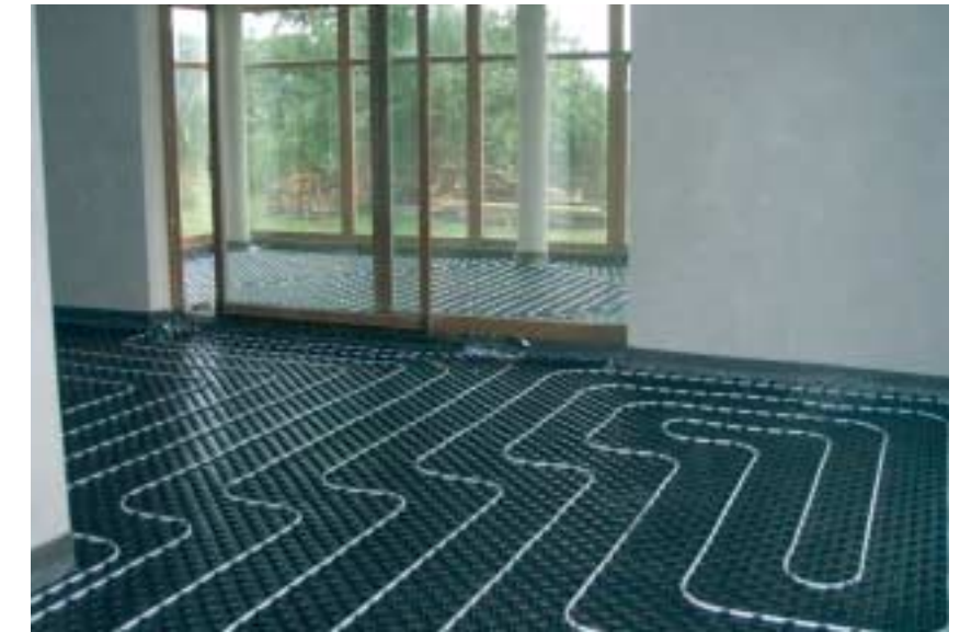
Podlahové topení je vhodné pro všechny typy interiérů - sys. deska ND 30N s potrubím Alplex
