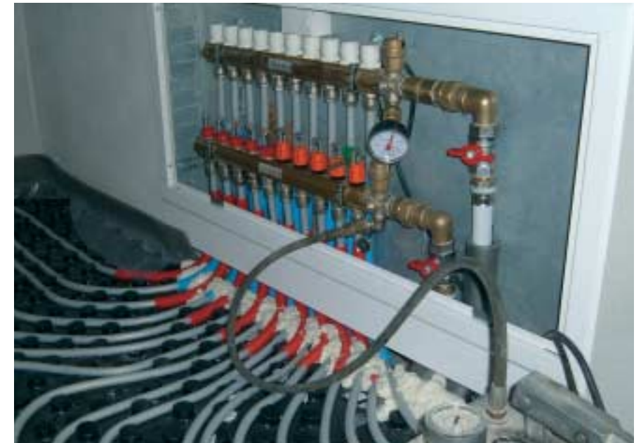
Základním předpokladem funkčnosti a spolehlivosti podlahového topení je provedení tlakové zkoušky před aplikací topné desky
